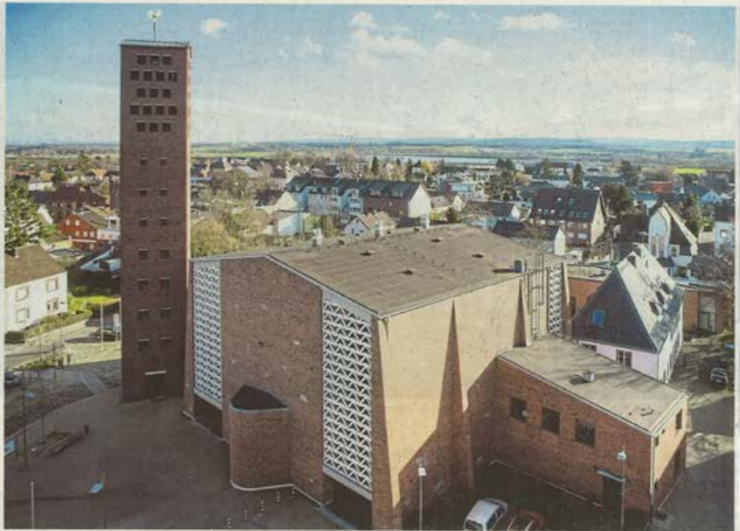
Auf dem nur gering geneigten Dach der Zülpicher Kirche könnte schon bald eine Photovoltaikanlage montiert werden. Foto: Tom Steinicke
